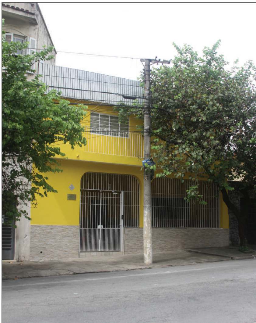
Fachada da FETHESP, na Vila Clementino, foi restaurada e recebeu nova pintura
