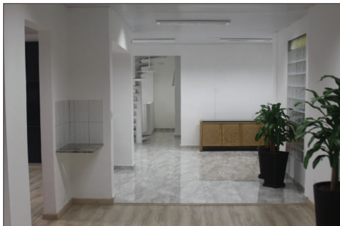
Foram instalados pisos laminado e de porcelanato no andar térreo
